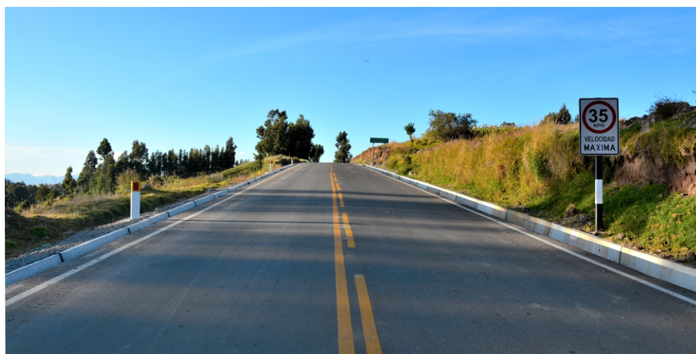
Culminación de asfaltado de la carretera Chupas-Chiara
