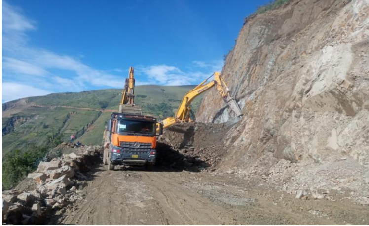
CORTES, CARGUIO Y ELIMINACION DE MATERIAL KM. 10+410 al 10+660
