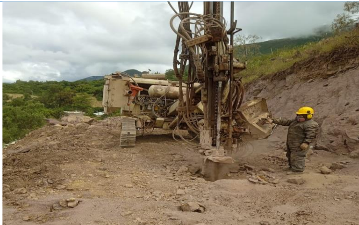
PERFORACION DE SECTOR DE ROCA CON ROCKDRILL KM. 3+110 AL 3+710
