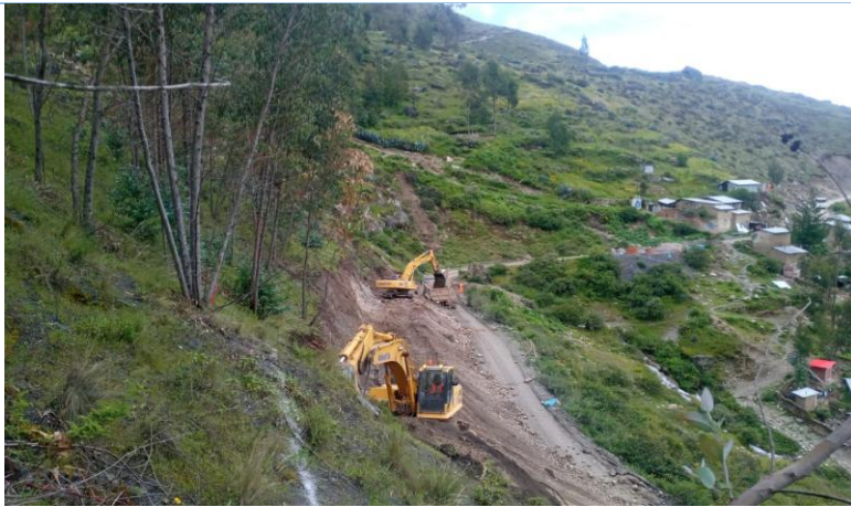
CORTES, CARGUIO Y ELIMINACION DE MATERIAL KM. 35+000 AL 36+000
