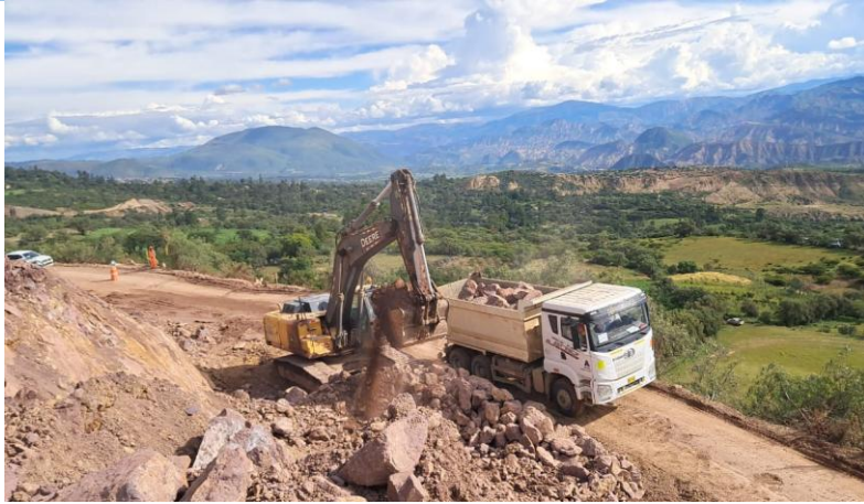
CORTES, CARGUIO Y ELIMINACION DE MATERIAL KM. 3+110 AL 3+710
