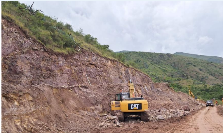
CORTES, CARGUIO Y ELIMINACION DE MATERIAL KM. 3+110 AL 3+710
