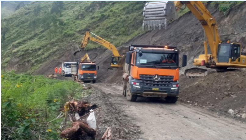
CORTES, CARGUIO Y ELIMINACION DE MATERIAL KM. 20+800 al 20+960
